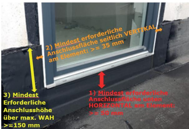
Es ist darauf zu achten, dass sich die untere und seitliche Ansehlussebene möglichst in einer Ebene befinden, um Tiefensprünge zwischen seitlichem Fensterrahmen und unterem Anschlussprofil zu vermeiden!
