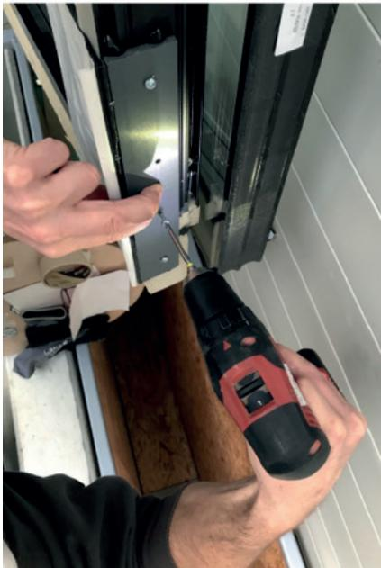
3. Verschrauben des Flansches mittels der mitgelieferten Schrauben in das Element
