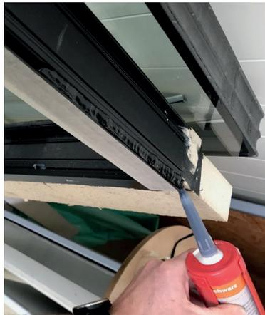
In weiterer Folge sind die beiden Hohlkehlen am Andichtflansch mit RALMO FIX ALL SEASONS Dichtstoff zu füllen und der Andichtflansch mit dem Rahmenrücken (in die thermische Trennung) zu verschrauben. Im Anschluss daran, ist das ausgetretene Material des RALMO FIX ALL SEASONS zu entfernen.
