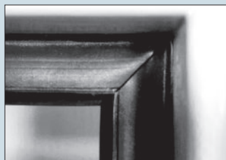
Dichtungsmontage Rahmenstock: richtig ✓
